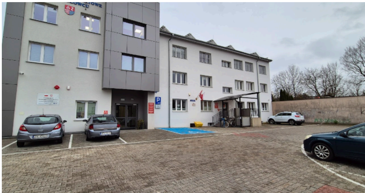
Zdjęcie 1. Kierowca srebrnego Opla zaparkował pod samym wejściem do budynku. Gdyby się pomylił i zaparkował po prawej stronie linii to zablokowałby wejście do budynku.
