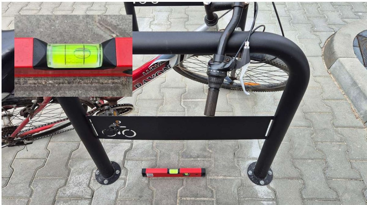
Zdjęcie 2. Stojaki zostały zamontowane wzdłużnie do pochylenia gruntu. Powoduje to samoczynne “wyjeżdżanie” roweru do tyłu (co widać na załączonym zdjęciu).
